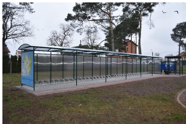
Wiaty rowerowa wyposażona w panel fotowoltaiczny ze stacją naprawy rowerów (Stacja BikeStop)
