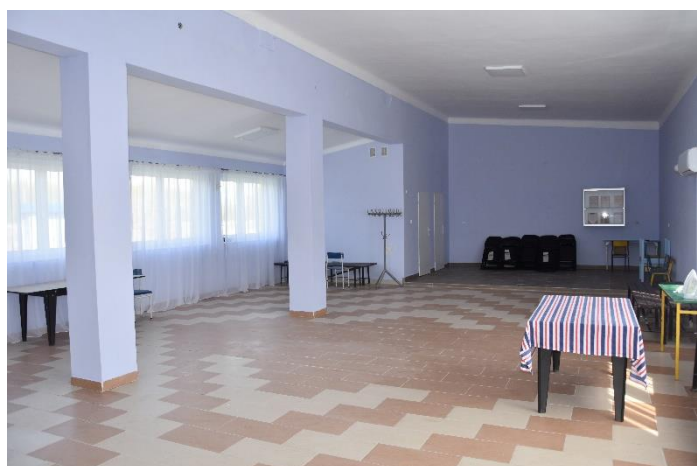
MIAS MAZOWSZE 2020 Remont świetlicy w miejscowości Kondrajec
