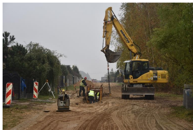
budowa sieci kanalizacji sanitarnej na terenie aglomeracji Sochocin
