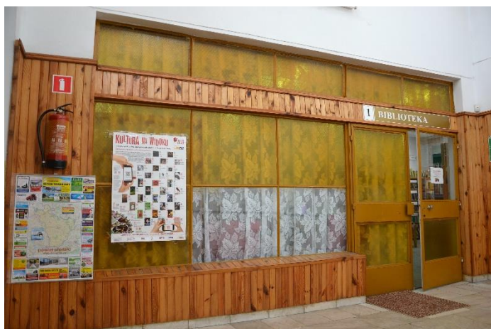
Witryna wejściowa do biblioteki przed remontem
