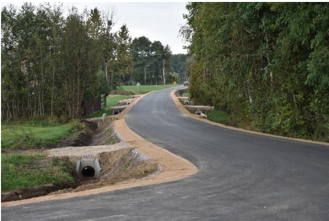
Przebudowa drogi gminnej nr 301142W w miejscowości Żelechy
