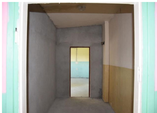
MIAS MAZOWSZE 2020 Remont świetlicy w miejscowości Gutarzewo
